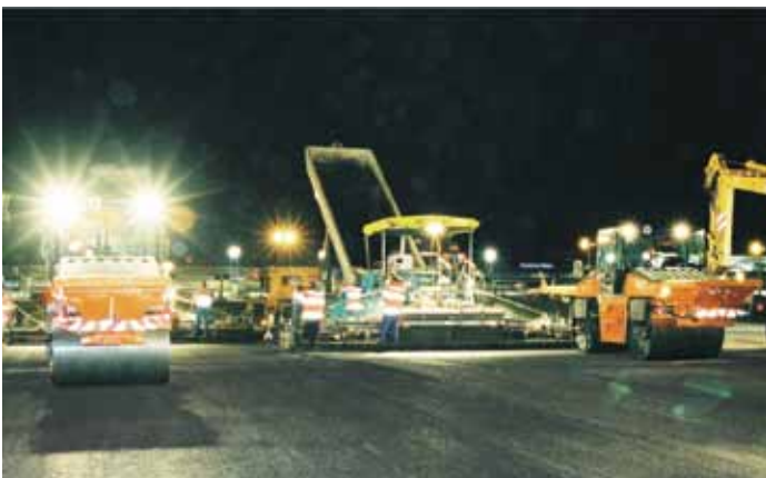
Straßenbau just in time: Die Start- und Landebahn Nord am Frankfurter Flughafen.
