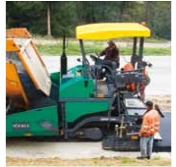
Ein moderner Straßenfertiger im Einsatz.
